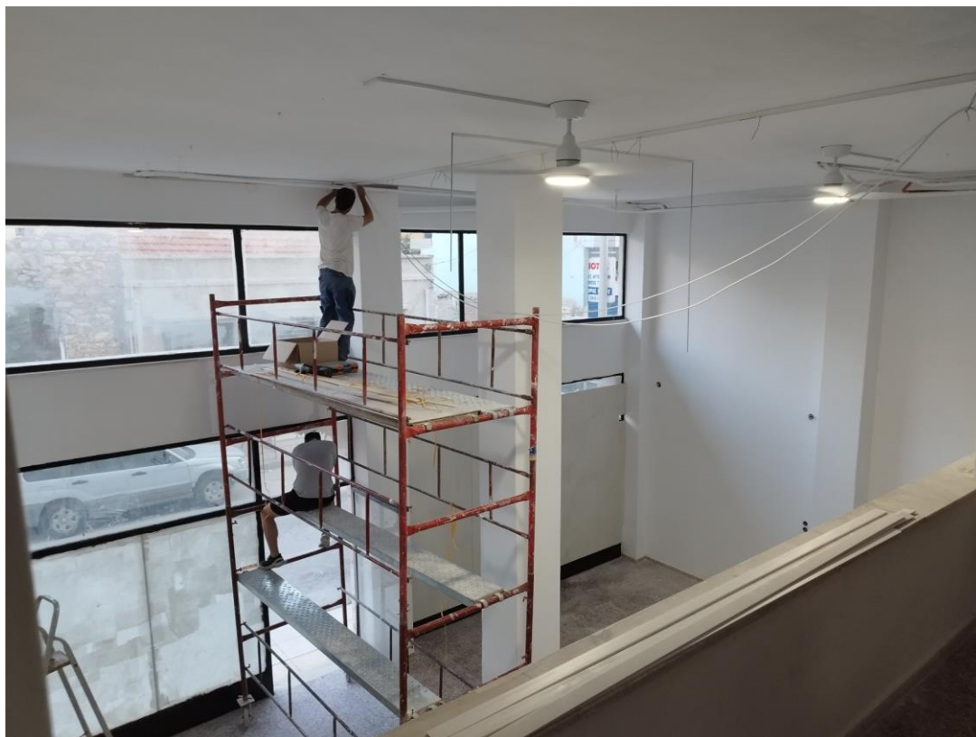
Εικόνα 4.1. Στιγμιότυπο από τις εργασίες εγκατάστασης ηλεκτρικών καλωδίων και φωτισμού (29/7/2024).
